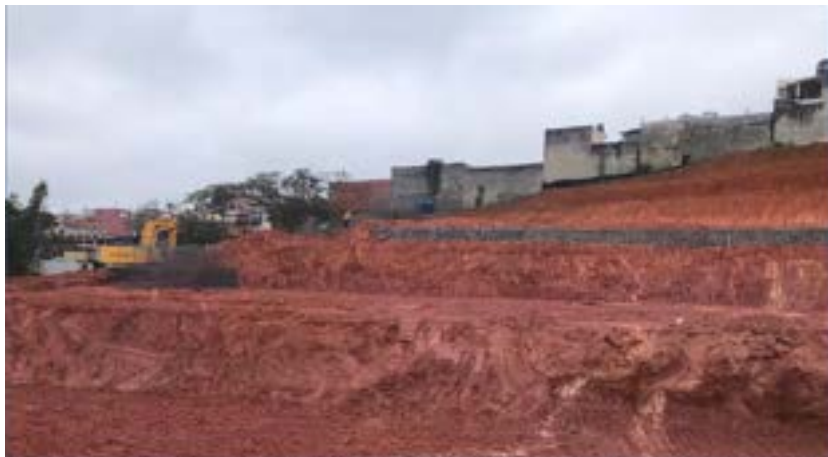
Terraplanagem e Contenções
