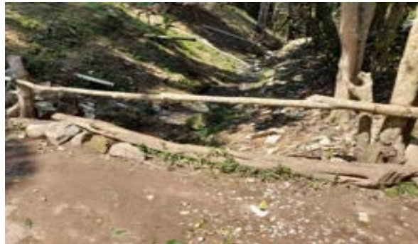
Vistoria técnica – Local da obra
