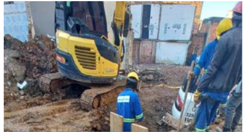
Oras de infraestrutura em andamento
