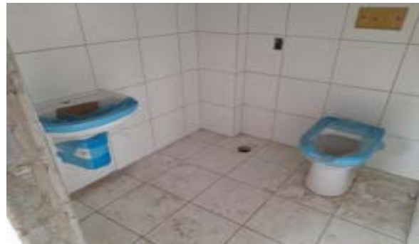
BLOCO A – Instalação de louças
