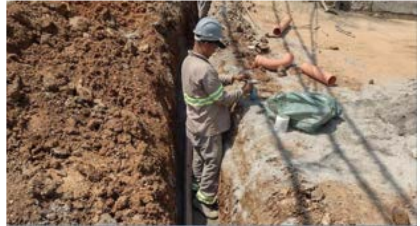
Rede de esgoto em andamento
