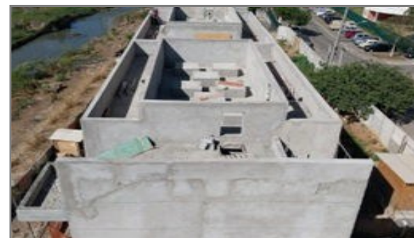
Condomínio 3 – Bloco 2,3 e 4 – revestimento externo
