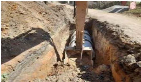
Execução de rede de drenagem
