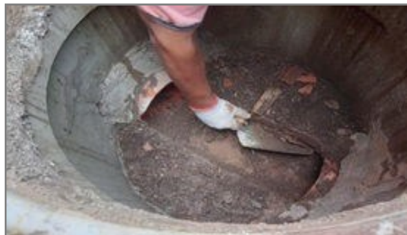
Limpeza da rede de esgoto que atravessa o canteiro de obras
