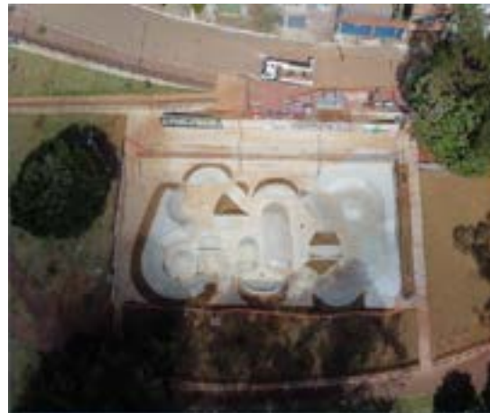
Etapa 02 – pista de skate em obras
