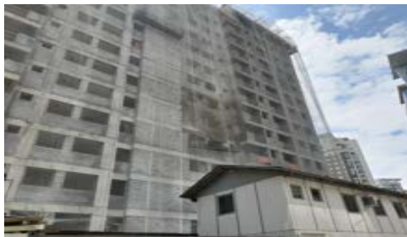
Chapisco da fachada
