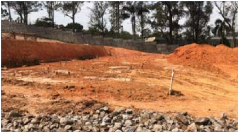
Estacas bloco D – Lote 02 executadas
