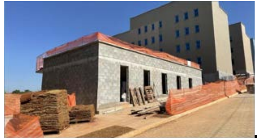
Execução de Conjunto Habitacional
