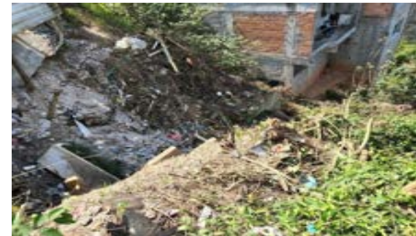
Vistoria técnica – Local da obra
