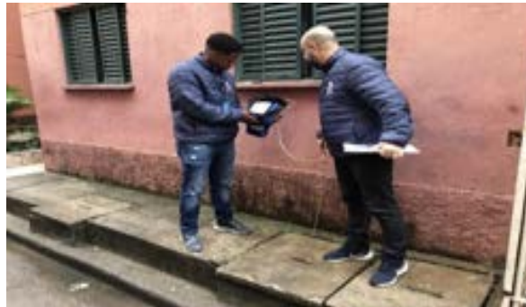
Monitoramento da caixa de esgoto
