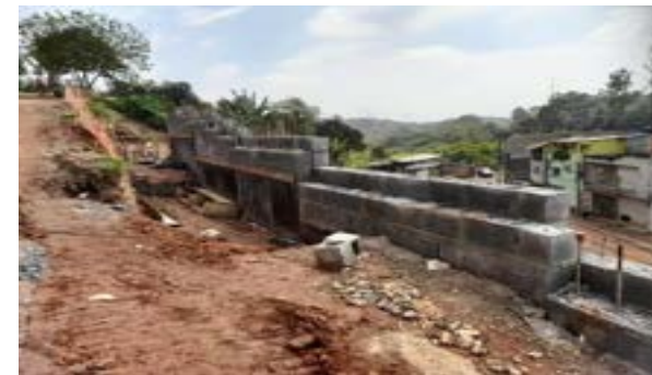
Núcleo Lágrima de Cristo – Muro de arrimo
