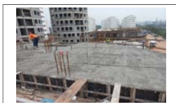
Condomínio 5 – Bloco 7 – Concretagem da laje do 3º pavimento
