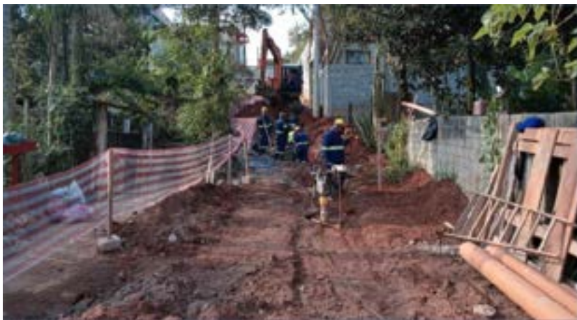
Implantação da rede de drenagem
