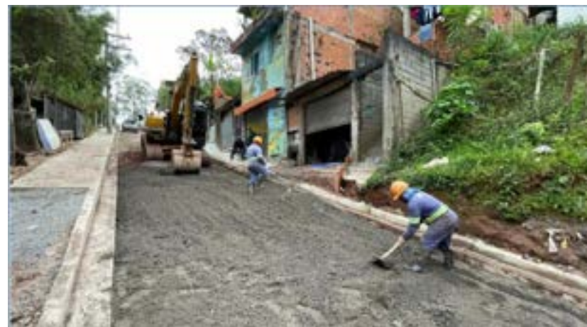
Preparo da via para pavimentação
