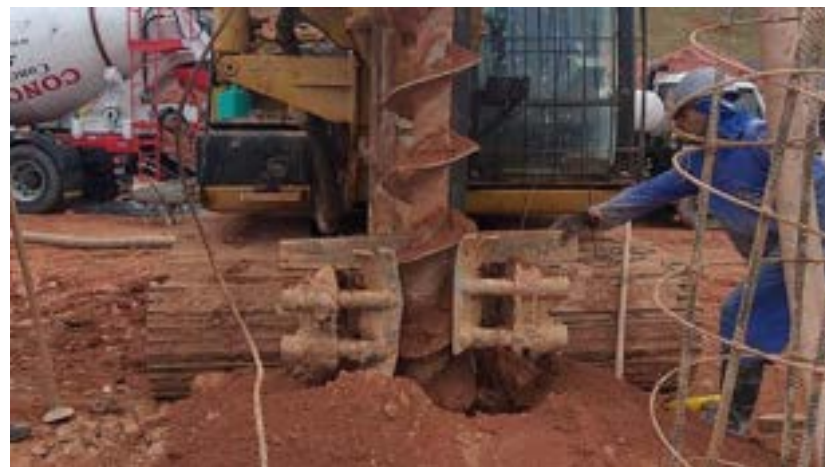
Fundação em andamento
