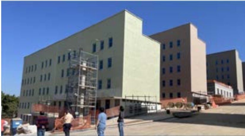
Execução de Conjunto Habitacional
