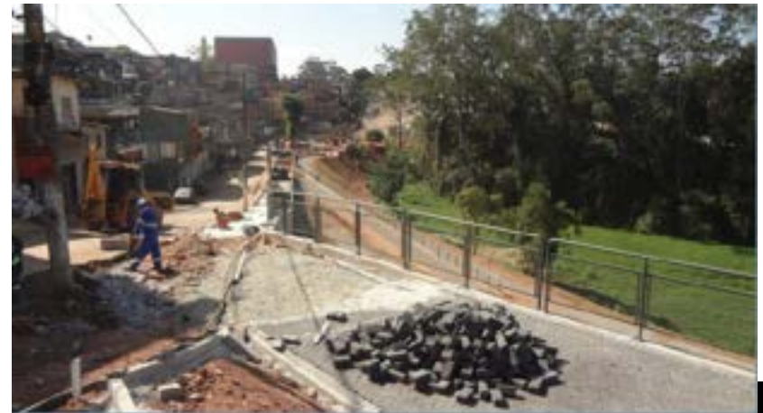
Pavimentação em execução
