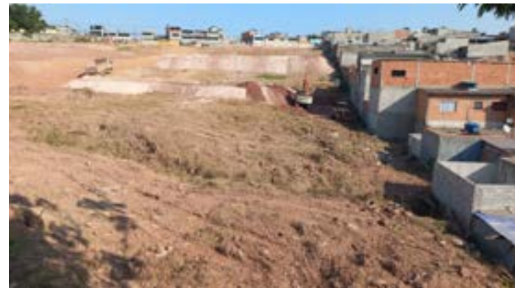
Serviços de terraplenagem
