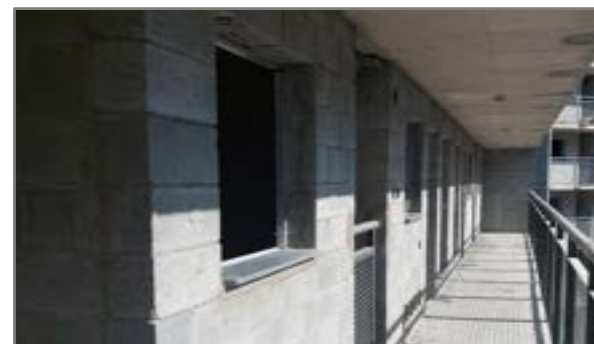
Corredor de acesso aos apartamentos
