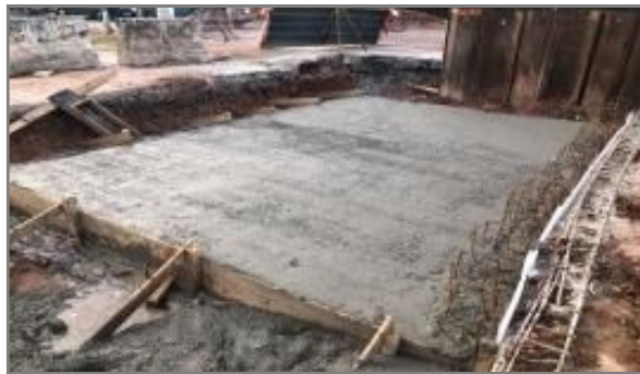
Concretagem de laje do Canal – Trecho 3
