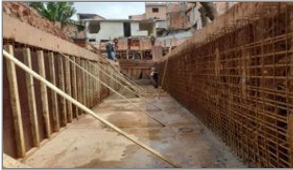
Forma e armação das paredes do Canal – Trecho da 2ª Fase
