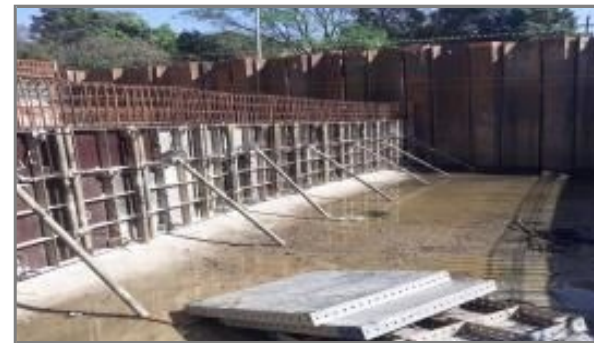
Escoramento de laje do Canal – Trecho 3
