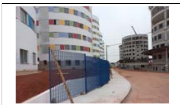
Condomínio 4 – Fechamento em gradil
