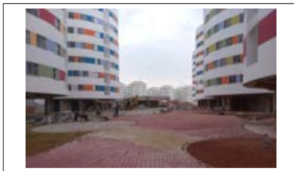
Condomínio 4 – Bloco intertravado
