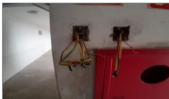
Execução do cabeamento para iluminação
