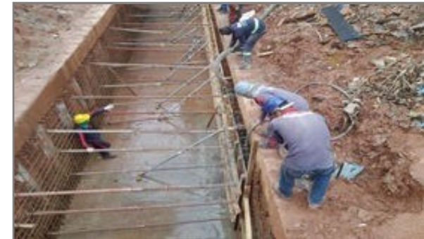
Concretagem da parede lateral do Canal – Trecho da 2ª Fase
