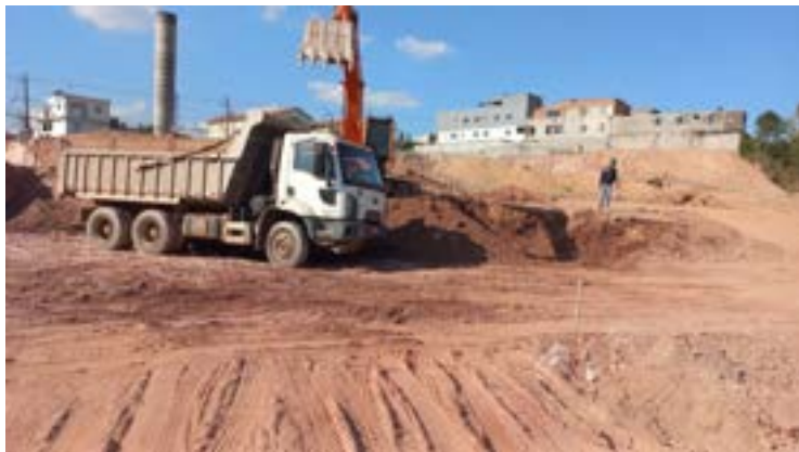
Serviços de terraplenagem
