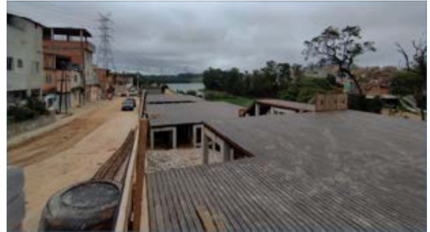
Parque Linear em execução
