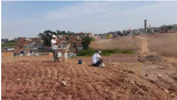
Serviços de terraplenagem
