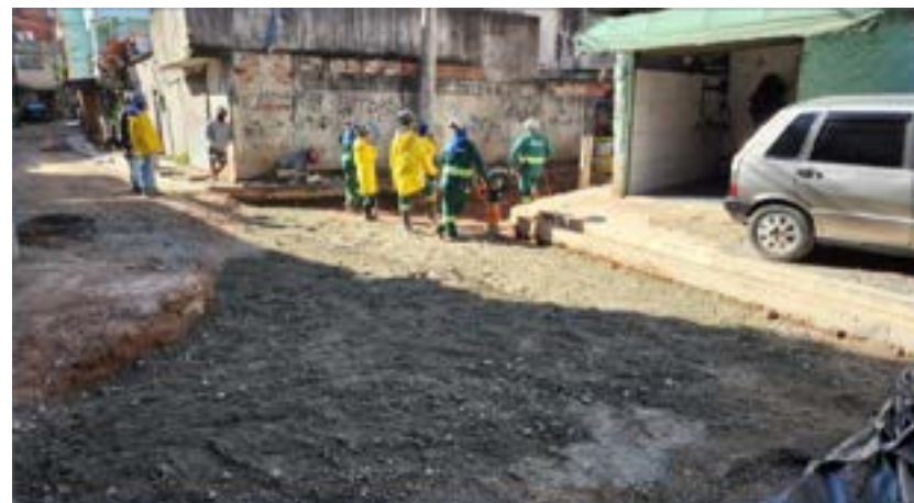
Rua da Paz – Concreto magro para pavimentação
