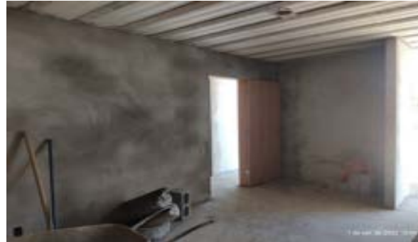
BLOCO C – Reboco das unidades
