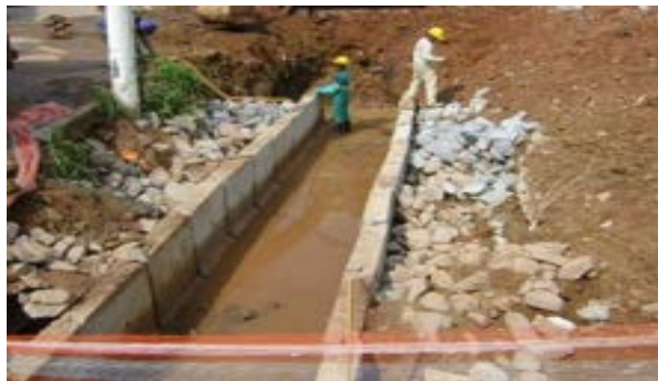
Núcleo Sálvia – Canalização de córrego
