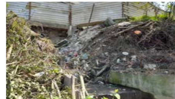
Vistoria técnica – Local da obra
