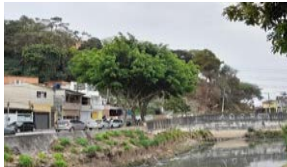
Vista do local onde se realizará as obras
