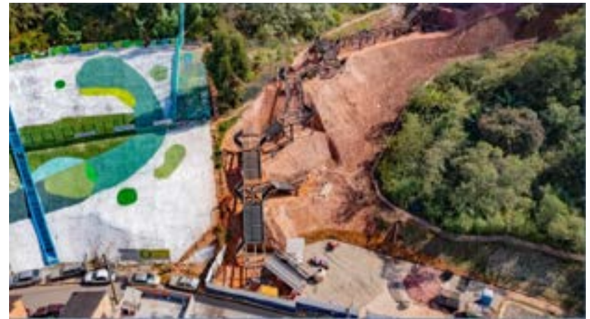
Deck em andamento
