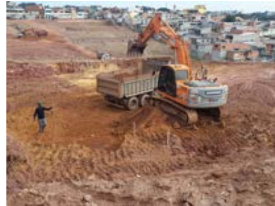
Serviços de terraplenagem
