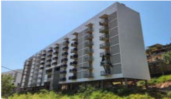
BLOCO A - Panorâmica
