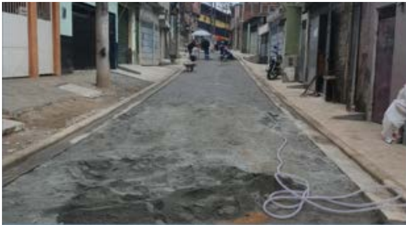
Oras de infraestrutura em andamento
