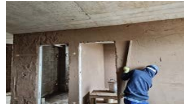
Torre A – 9º andar – Aplicação de reboco
