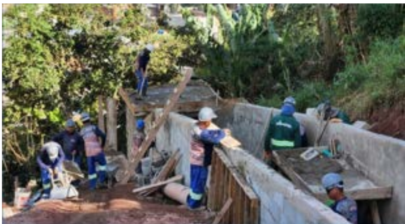
Encosta Citadella - Execução escada hidráulica trecho 16
