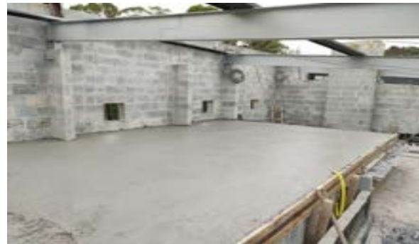
BLOCO E – Concretagem da laje do reservatório
