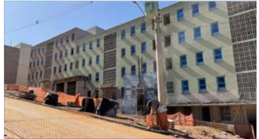
Execução de Conjunto Habitacional
