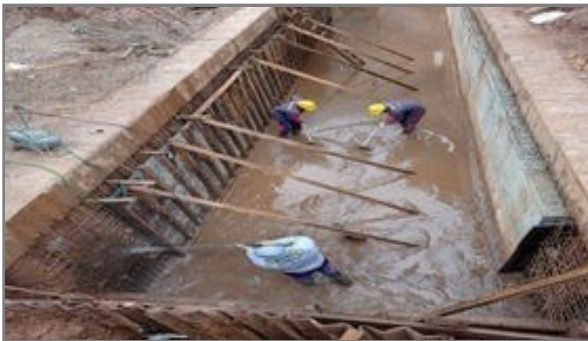
Execução da forma da parede oposta do Canal – Trecho da 2ª Fase
