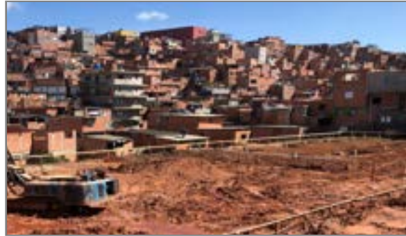
Execução da estaca raiz
