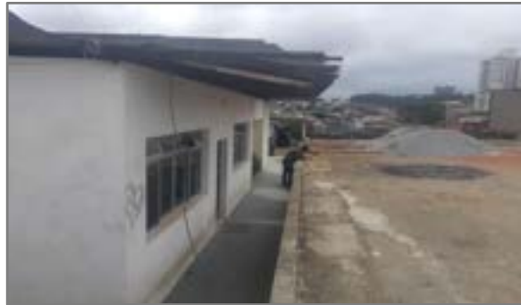
Implantação do canteiro de obras
