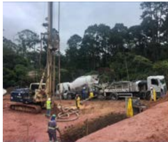
Fundação em andamento
