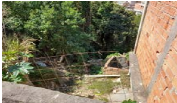
Vistoria técnica – Local da obra
