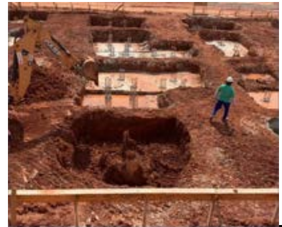
Fundações em andamento
