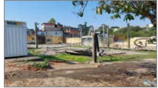
Condomínio C - Demolição
