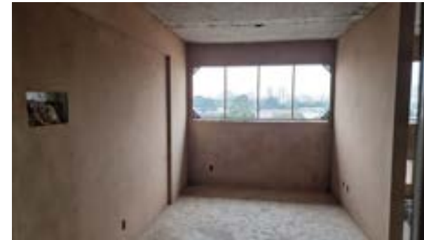
Torre B – Execução do emboço
