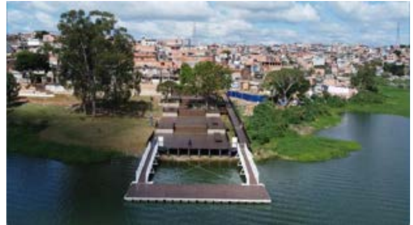
Etapa 02 – deck finalizado
