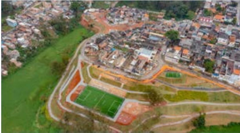
Parque Linear em execução
