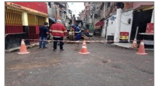
Auxílio a concessionária SABESP para o desligamento das moradias que serão demolidas
