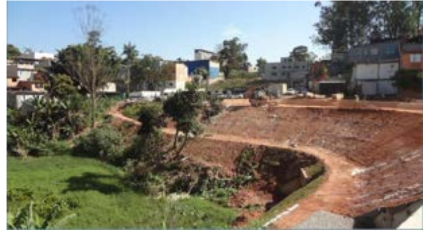
Parque Linear em execução
