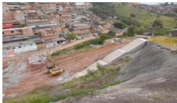
Núcleo Antúrios – Canalização de córrego
