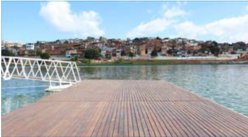
Etapa 02 – deck finalizado
