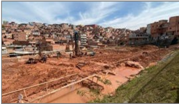
Vista do terreno
