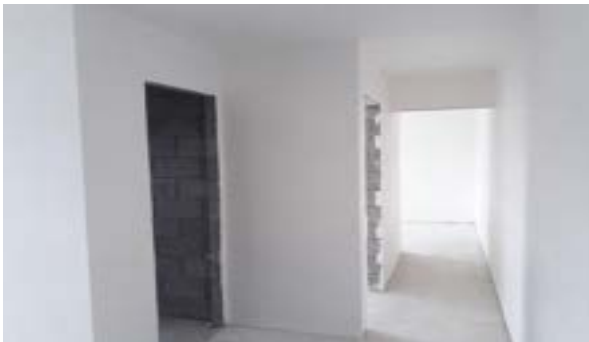
Revestimento interno com gesso liso
