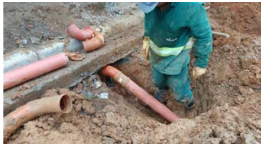
Rebaixamento dos ramais da rede de esgoto para execução da pavimentação
