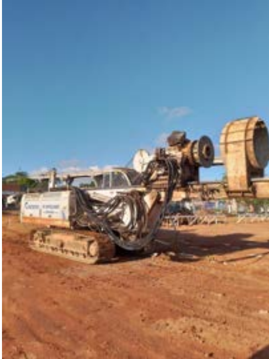
Serviços de terraplenagem
