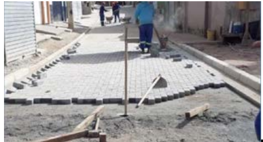
Oras de infraestrutura em andamento
