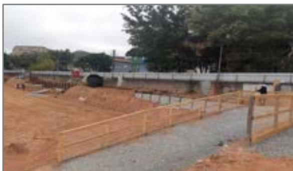
Terraplenagem – Nível do 1º pavimento inferior
