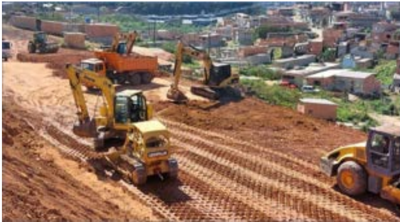
Serviços de terraplenagem
