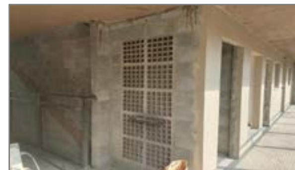
Área da escada e corredor de acesso aos aptos
