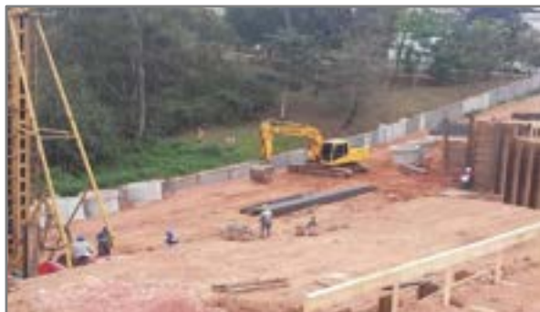
Terraplenagem e estacas do 3º pavimento inferior
