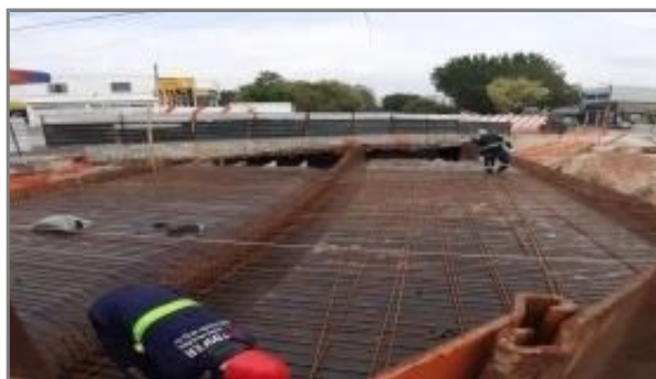
Armação de laje do Canal – Trecho 3
