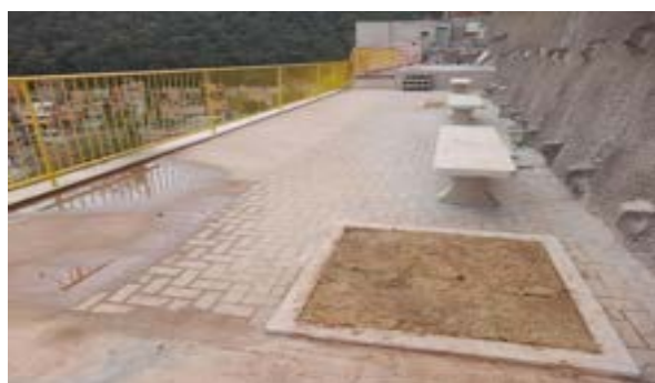
Núcleo São Jorge – Execução de urbanismo
