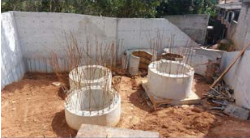
Obras de infraestrutura
