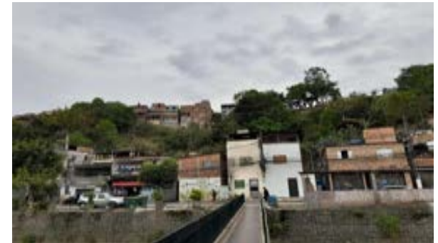
Vista do local onde se realizará as obras
