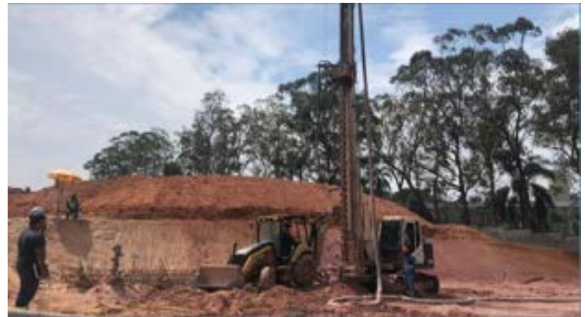
Fundação em andamento
