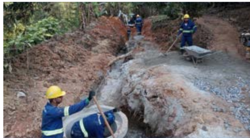
Implantação da rede de drenagem
