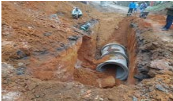
Execução de rede de drenagem
