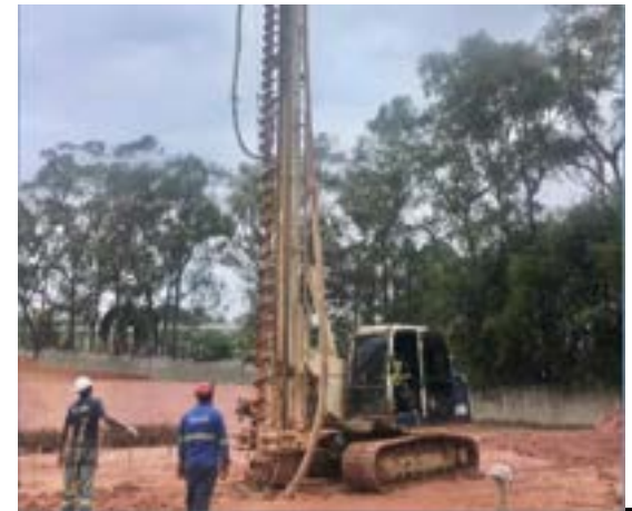
Fundação em andamento
