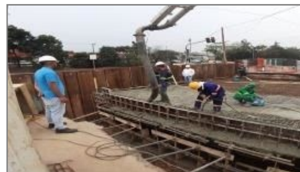
Concretagem de laje do Canal – Trecho 3
