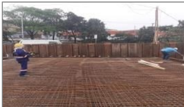
Armação de laje do Canal – Trecho 3
