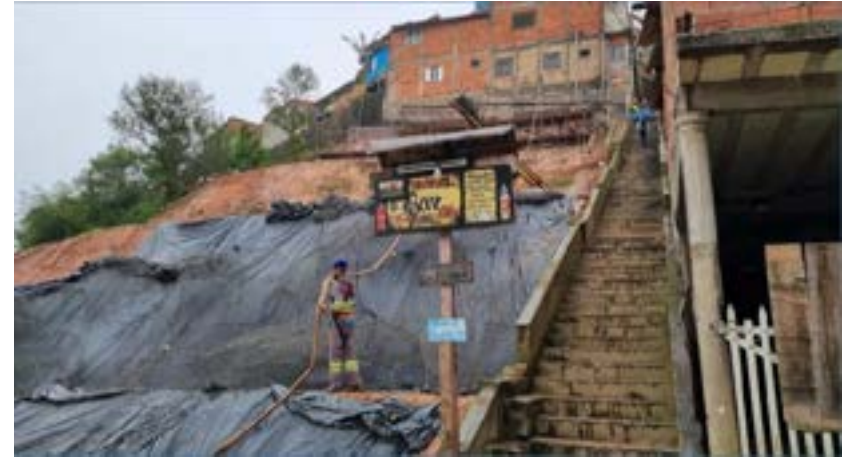
Contenção de encosta em execução
