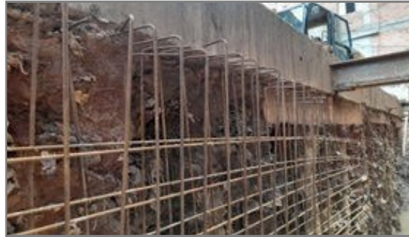
Armação da parede lateral oposta do Canal – Trecho da Fase 2ª
