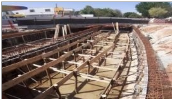
Escoramento de laje do Canal – Trecho 3
