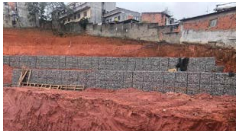
Terraplanagem e Contenções
