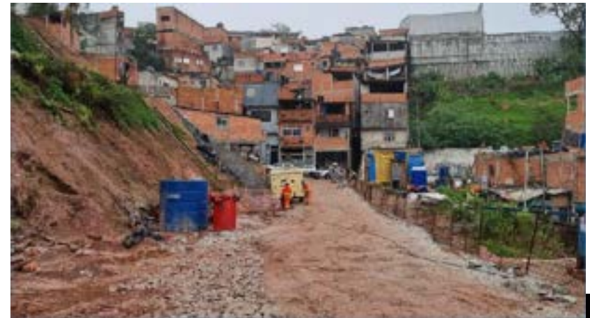
Contenção de encosta em execução
