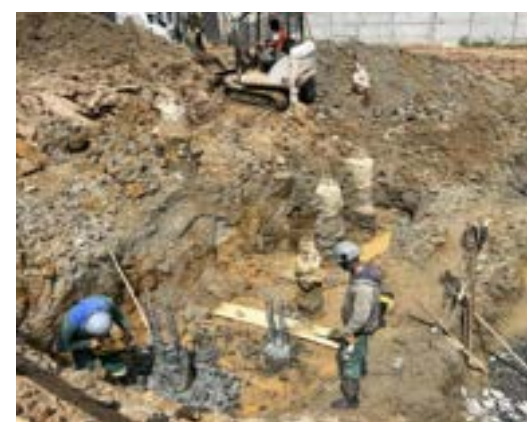
Execução das Fundações Torre 06
