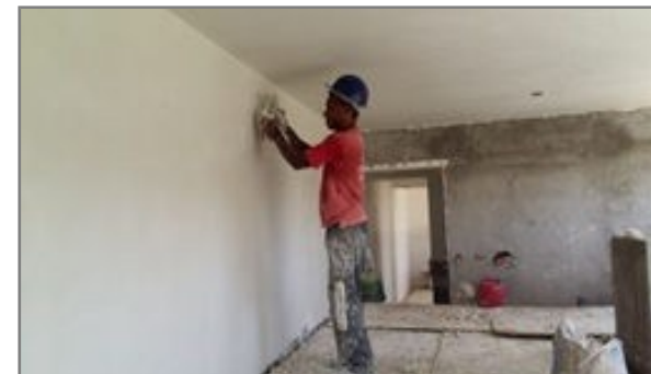
Condomínio 3 – Bloco 2,3 e 4 – Revestimento interno
