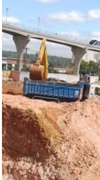
Serviços de terraplenagem
