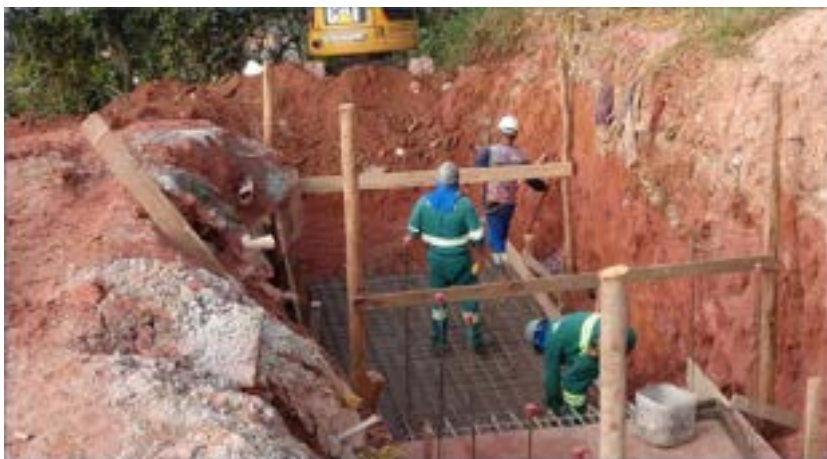
Encosta Citadella - Execução escada hidráulica trecho 16
