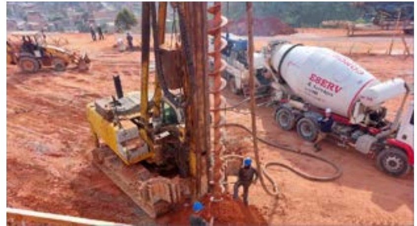
Fundações em andamento
