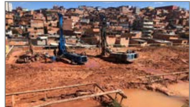
Execução da estaca raiz
