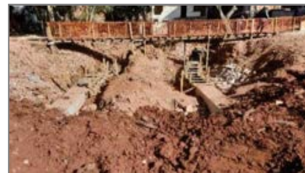
Forma e armação da viga de coroamento – Trecho da 2ª Fase
