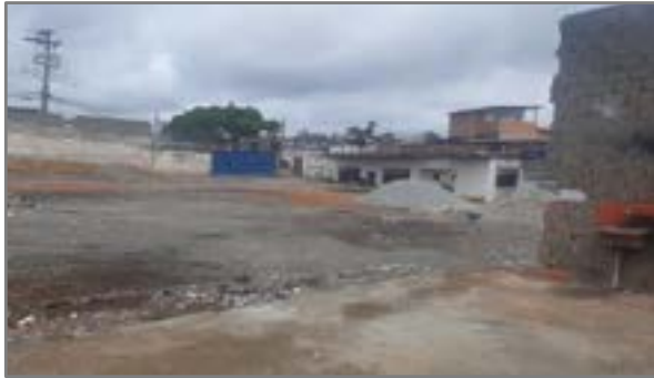
Limpeza do terreno
