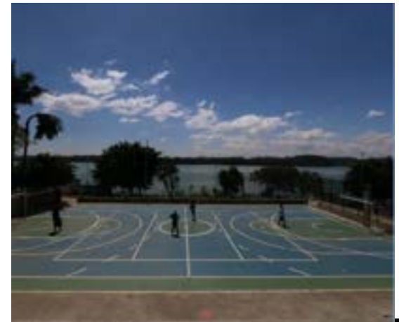
Etapa 02 – quadra finalizada
