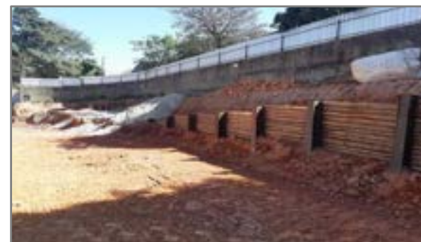
Cond. 1 – Consolidação Geotécnica - Muro
