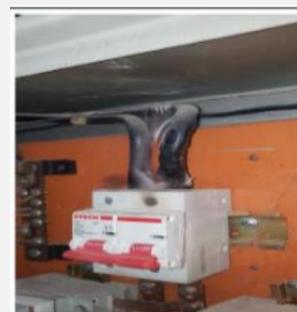
Disjuntor necessita de substituição devido a curto.
